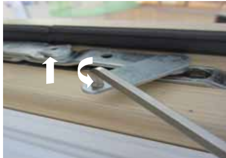
Aushängen oben bei Schere
