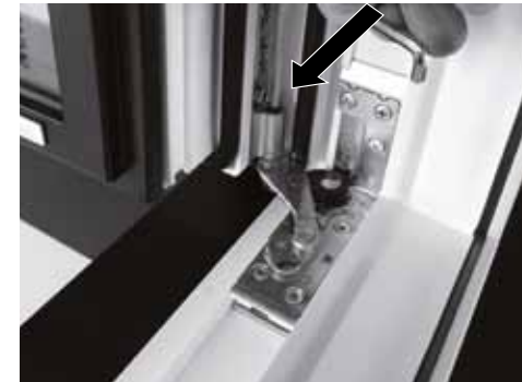
Höhenverstellung Inbus M4
